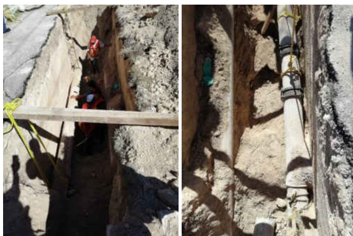
Figura II. 7 Trabajos de reparación de la Fuga en la línea de conducción de Agua Potable.
