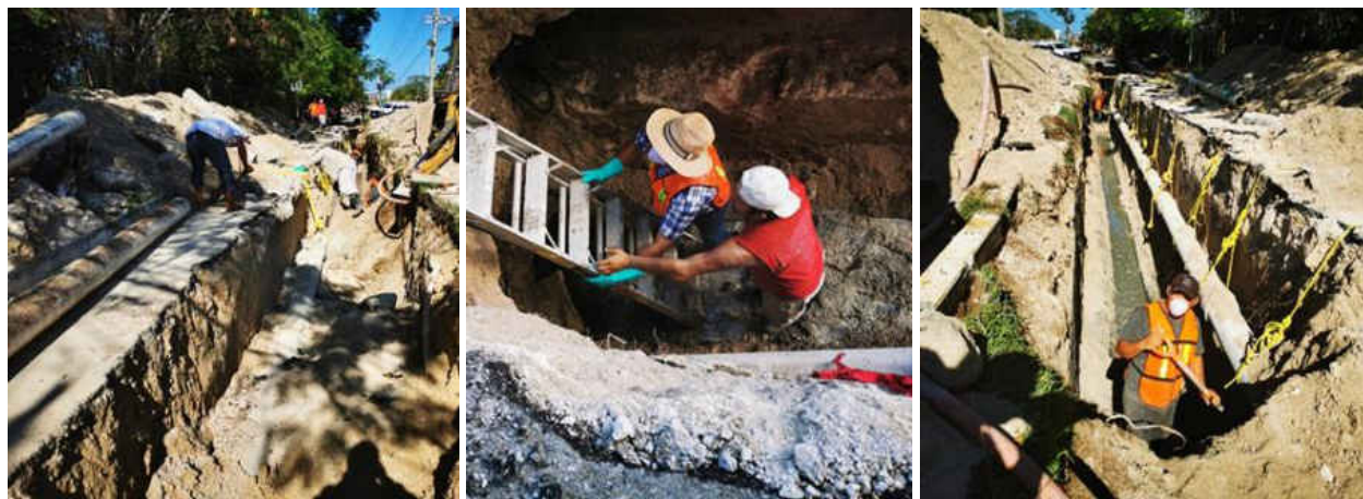
Figura II. 3 Trabajos de localización, desazolve y retiro de material producto del colapso en el colector Rafael E. Melgar.
