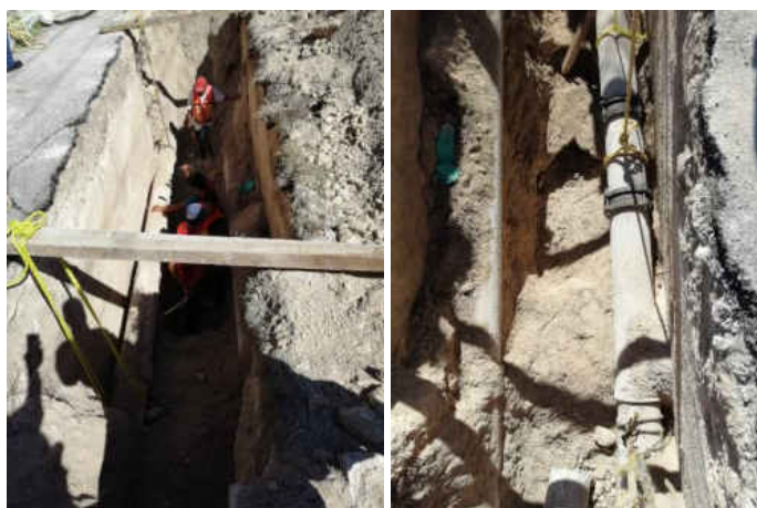
Figura II. 9 Trabajos de reparación de la Fuga en la línea de conducción de Agua Potable.
