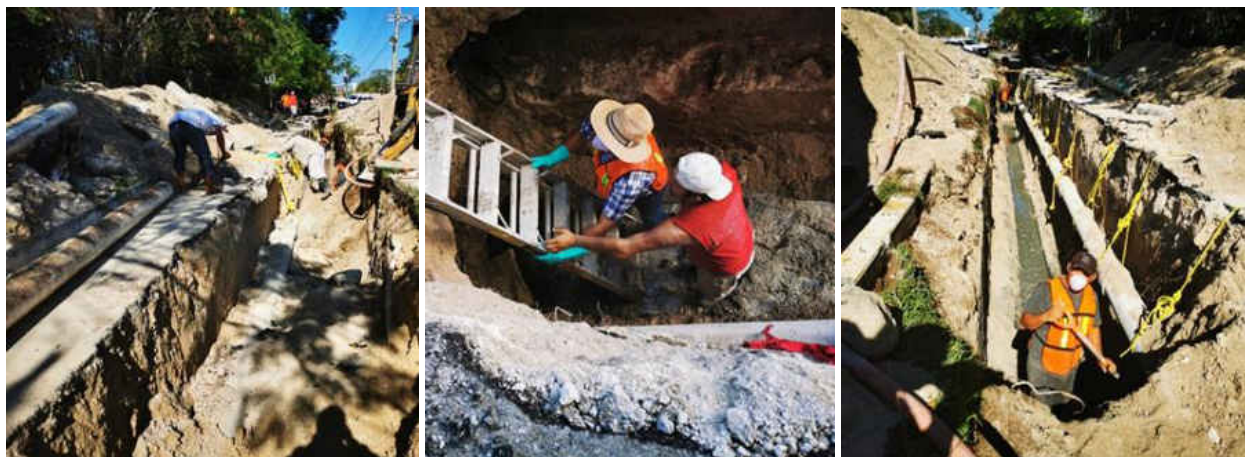
Figura II. 10 Trabajos de localización, desazolve y retiro de material producto del colapso en el colector Rafael E. Melgar.
