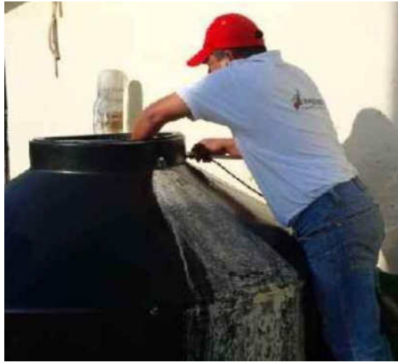
Figura II 11 Limpieza de tinaco por exceso de sarro.
