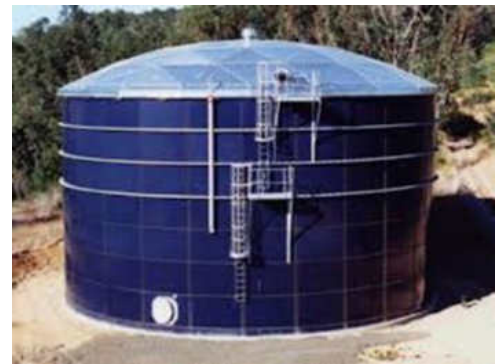
Figura III 4 Imagen ilustrativa de tubería de hierro dúctil U un tanque de 500 m3 vidrio fusionado al acero
