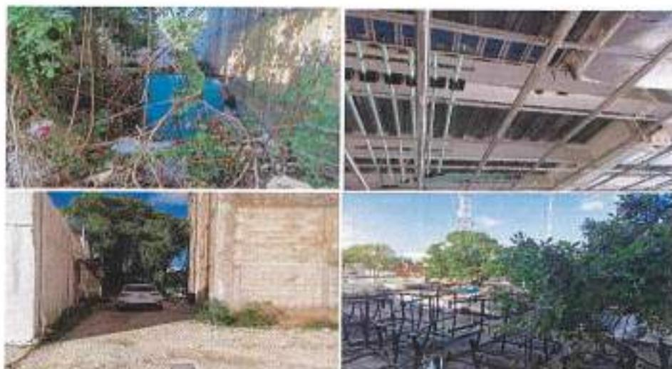
El entorno exterior presenta signos de abandono, con maleza y materiales de construcción expuestos. En el interior del edificio, los sistemas estructurales muestran corrosión y daños en vigas y techos metálicos, lo que compromete la integridad física del inmueble. Las instalaciones eléctricas incompletas y la falta de acabados evidencian que la obra quedó en un estado parcial, aumentando los riesgos de seguridad.
