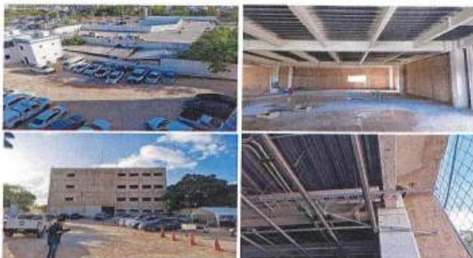
Se observan espacios severamente afectados por filtraciones y humedad extrema, con paredes enmohecidas y cubiertas dañadas. Los residuos y materiales acumulados en estos espacios, junto con las instalaciones eléctricas expuestas y dañadas, representan un riesgo para los usuarios. Estas áreas son completamente inutilizables y reflejan la urgencia de rehabilitar el edificio para cumplir con estándares de seguridad y funcionalidad adecuados.
