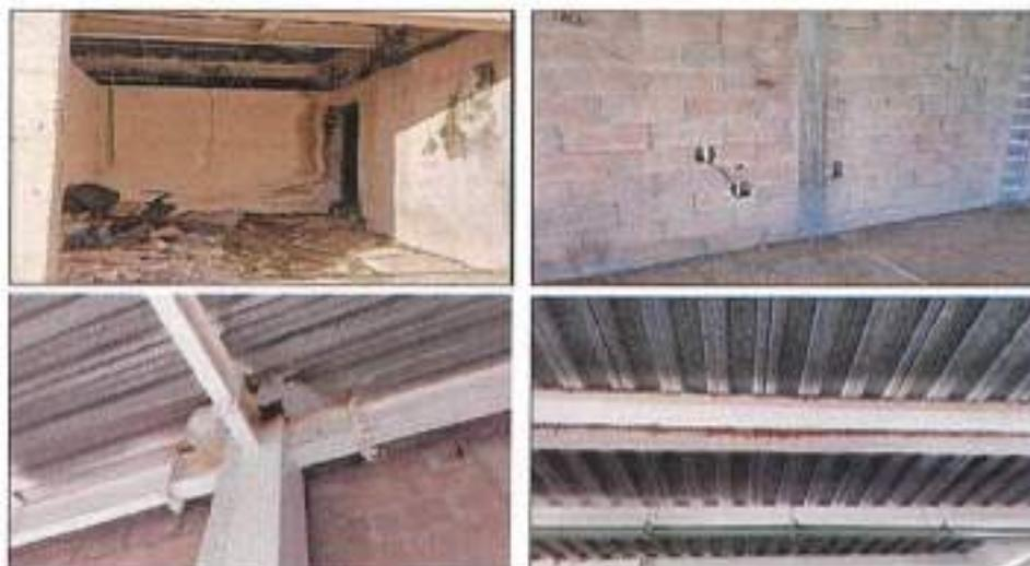
Las imágenes muestran el estado de abandono del edificio, evidenciado por áreas sin acabados en paredes y techos, charcos de agua en el piso y filtraciones. La presencia de humedad acumulada es notable, lo que ha provocado un deterioro progresivo en la estructura y materiales del inmueble. La falta de impermeabilización y mantenimiento ha permitido que las lluvias y la humedad propia de la región afecten el interior del edificio, generando un entorno poco seguro y poco funcional.
