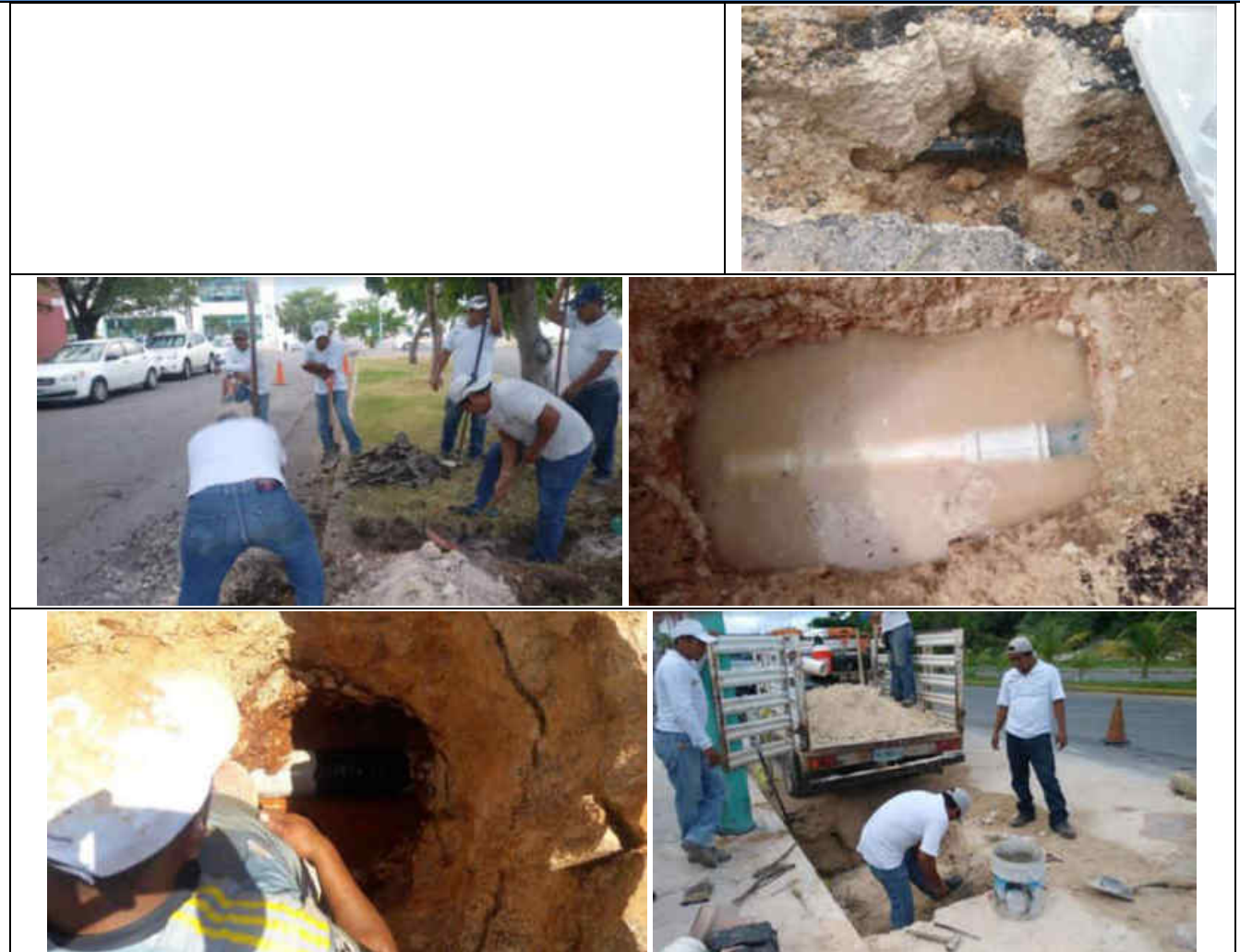
Figura II. 14 Fotos de reparaciones a tuberías de la red de distribución por fugas.
