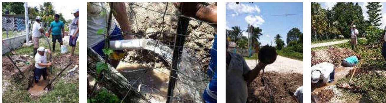
Figura II. 23 Fotos de reparación de fugas en tuberías de la red de distribución.
