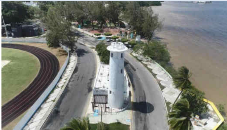
ESTADO ACTUAL DEL BOULEVARD DE CHETUMAL
